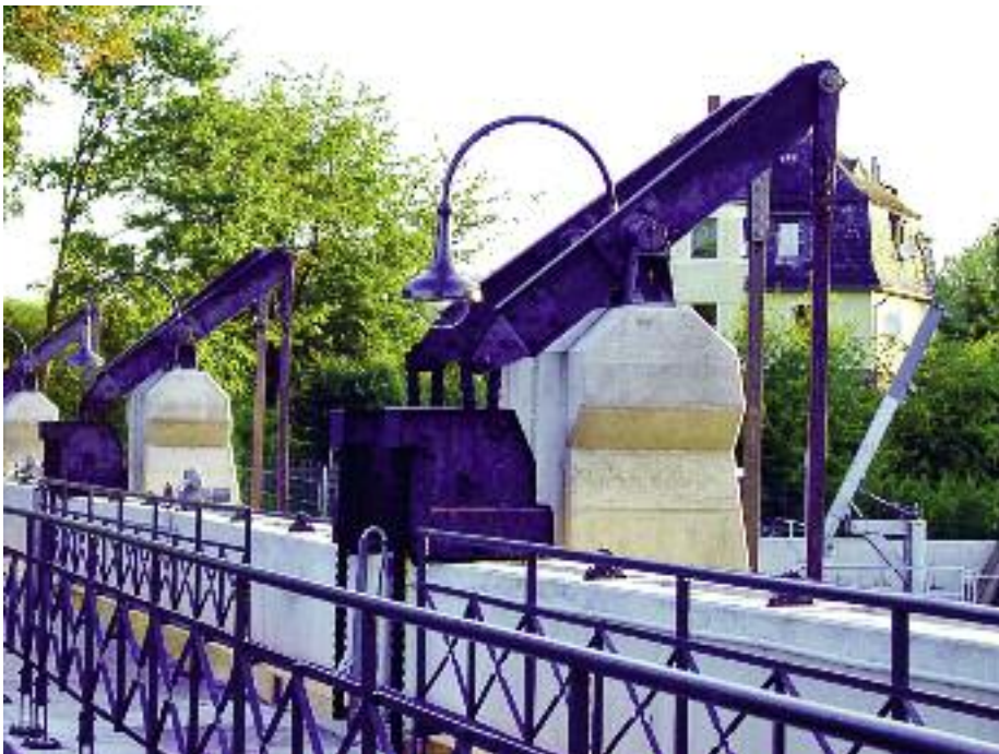
Erstrahlt in neuem Glanz - die denkmalgeschützte Wehranlage in Flöha-Plaue
